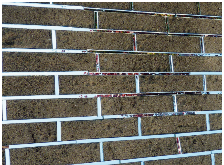
Mit Spiegelstreifen kann man eine Wand „durchsichtig“ machen.
